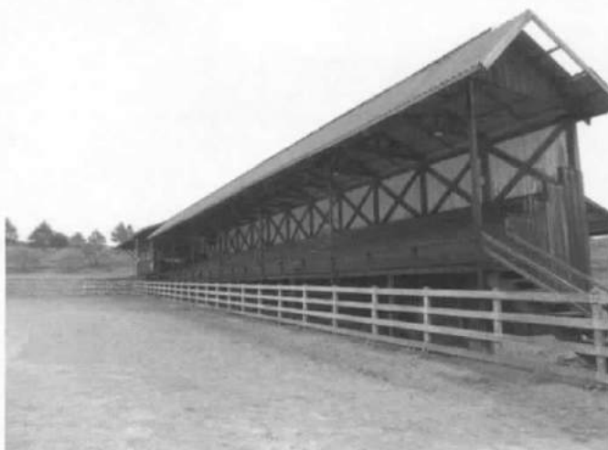
Galpão de Remates e Arquibancadas – item 6.4.5. do laudo: vista do galpão das arquibancadas e das baias.
