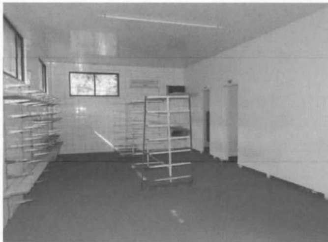
Tambo – item 6.4.22.: vistas internas
