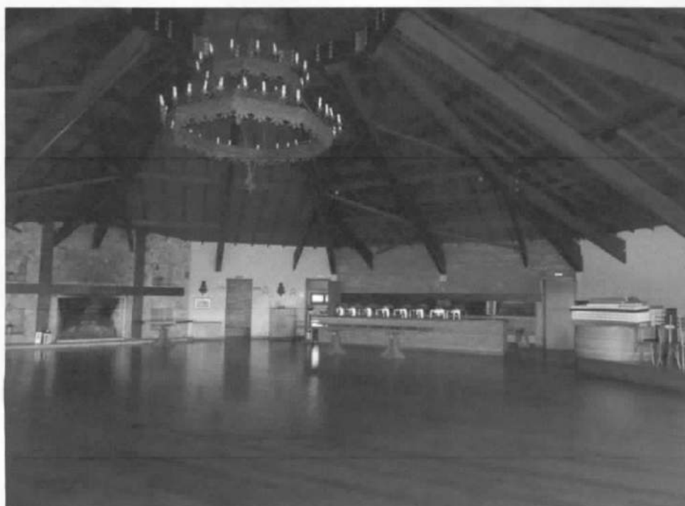
Prédio do Restaurante, descrito no item 6.4.1. do laudo – vista interna do salão do restaurante, no pavimento superior. Aspectos construtivos.
