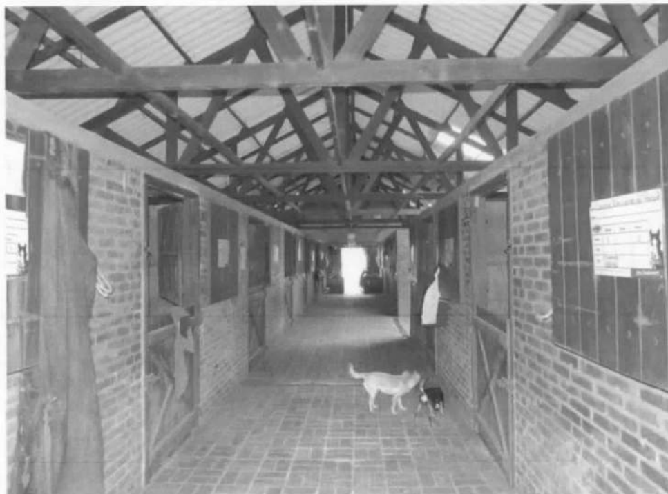
Galpão de Equinos – item 6.4.23.: vistas externa e interna.
