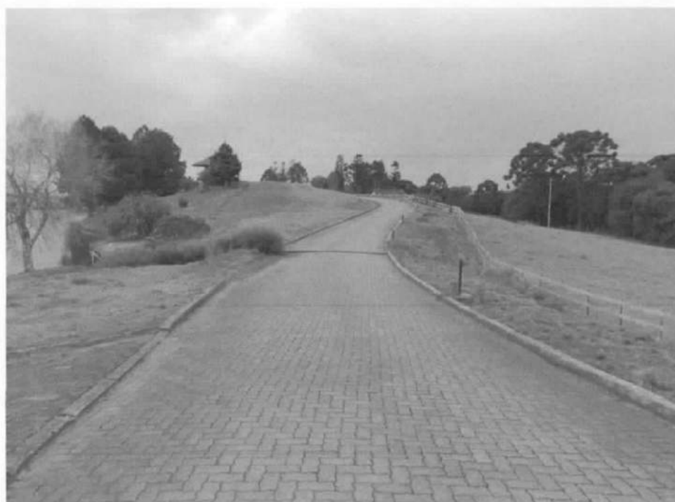
Pavimentações Externas – item 6.4.36.
