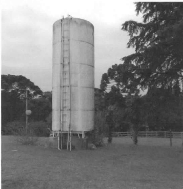
Casa de Máquinas e Reservatórios – item 6.4.31.
