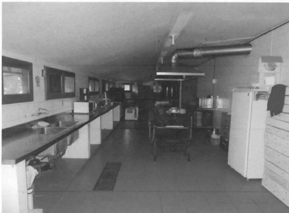
Prédio do Restaurante (item 6.4.1. do laudo): vista da cozinha, no pavimento superior.
