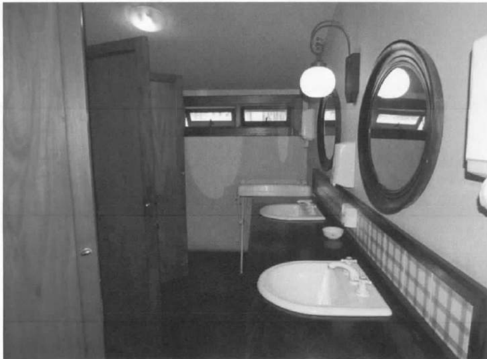
Prédio do Restaurante (item 6.4.1. do laudo): vista interna de sanitário.
