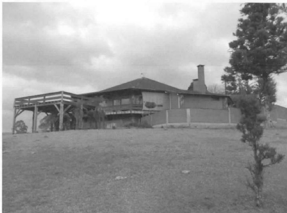
Prédio do Restaurante, descrito no item 6.4.1. do laudo
